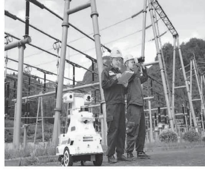
迎峰度夏期间，南方电网铜仁供电局利用智能机器人和无人机等设备，通过“人工巡检+智能巡检”方式，对核心枢纽变电站和重要输电线路加强巡检，全力保障电网安全可靠运行。图为在贵州省铜仁市220千伏木黄变电站内，运维人员和智能机器人一起开展“人机联合”巡检。
