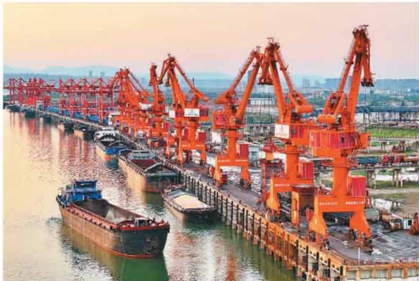
为满足大宗货物快捷、畅通运输需求, 江西省南昌市近年来大力推进智慧型码头、港口建设。位于南昌市的姚湾综合码头使用岸线总长1905米, 设计年吞吐量达散杂货1040万吨、集装箱15万标箱, 目前项目16个泊位主体结构已完工。图为姚湾综合码头现场, 起重机械卸作业正有序进行, 货船、货车往来繁忙。 朱海鹏摄 (人民视觉)
