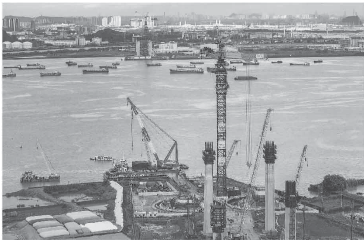
连日来，广州南沙狮子洋大桥工程建设如火如荼，现场塔吊林立、机器轰鸣。狮子洋大桥采用主跨2180米双层钢桁梁悬索桥的方案“一跨过江”，是粤港澳大湾区又一超级工程——狮子洋通道的控制性工程，计划2028年建成通车。图为狮子洋大桥建设现场。 邱新生摄（人民视觉）
